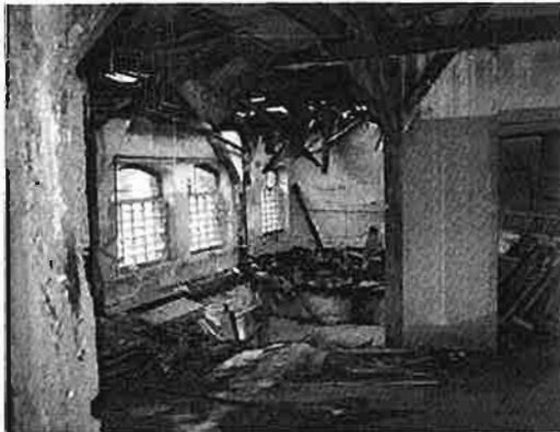
Abb. 6: zerstörte Holzbauteile durch Feuchteinwirkung im DG
