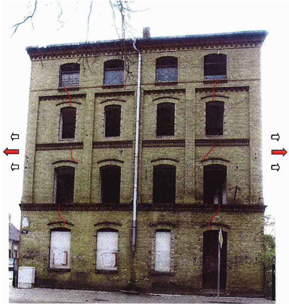
Abb. 8: Rissbildung im Mauerwerk
